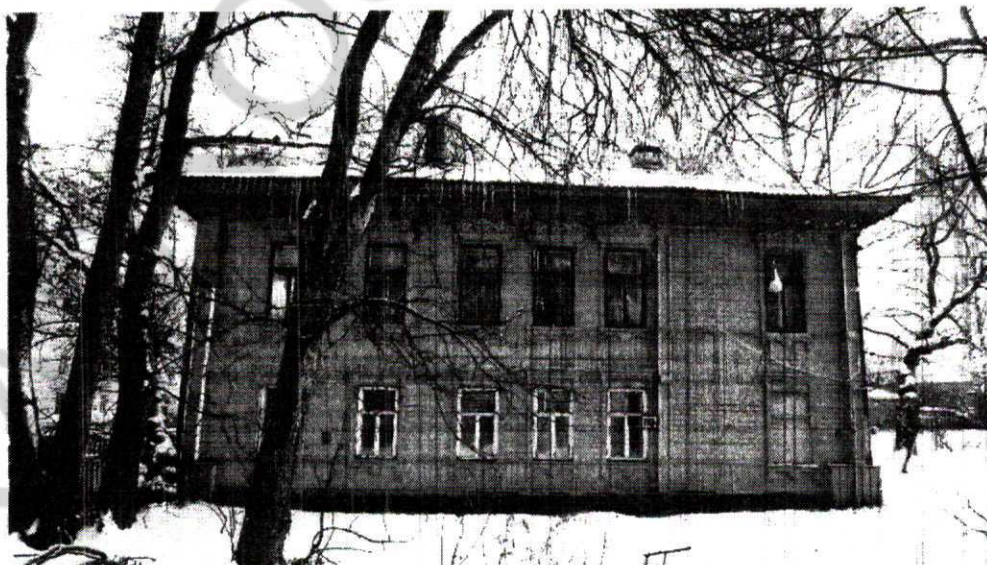
Фото 2. Вид со стороны дворового (южного) фасада
